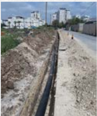
החלפת קו מים רחוב מיכה רייסר
