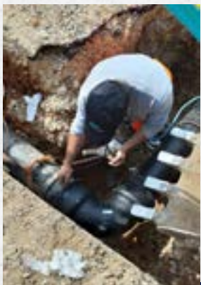
החלפת קו מים ברחוב מיכה רייסר
